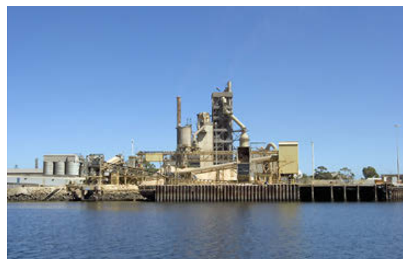
↑ Fabrique de Béton
