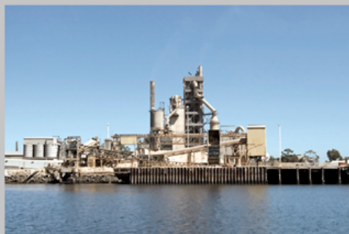
Fabrique de Béton
