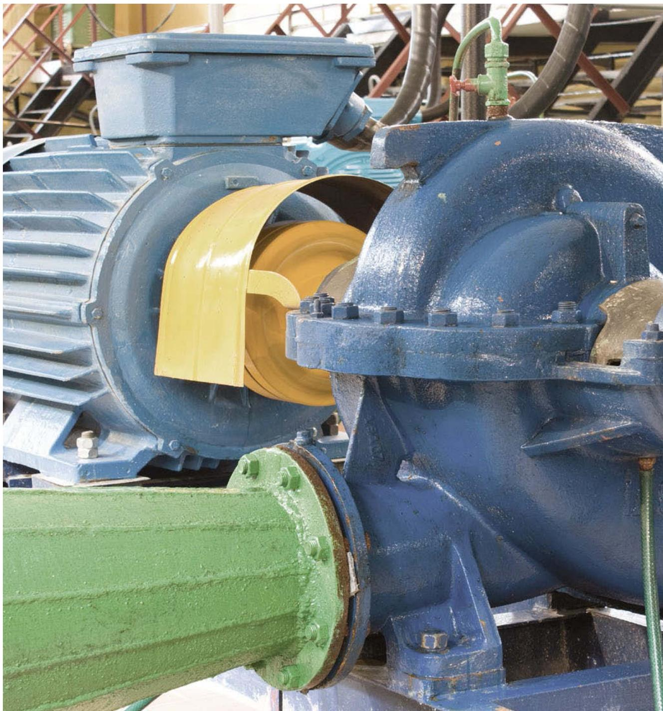
**Pompa centrifuga in un impianto di trattamento delle acqua di scarico** – I cuscinetti a sfere a contatto obliquo sono ampiamente utilizzati nelle pompe centrifughe e nei compressori a vite. Gli OEM ricercano macchine con un design sempre più compatto e questo porta ad un aumento del carico a cui vengono sottoposti i cuscinetti. La risposta a questo genere di problematiche è costituita dai cuscinetti a sfere a contatto obliquo della Serie HPS™.
